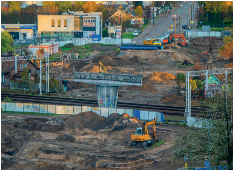
Największą inwestycją w przyszłym roku będzie budowa wiaduktu w ul. Żeromskiego
